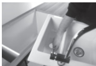
Trin 4: Løft vasken med den ene hånd i afløbshullet og den anden hånd på flangen...
