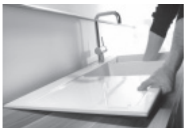
Trin 5: ...og forsigtigt, først med den bagerste del af vasken og derefter fronten af vasken.
